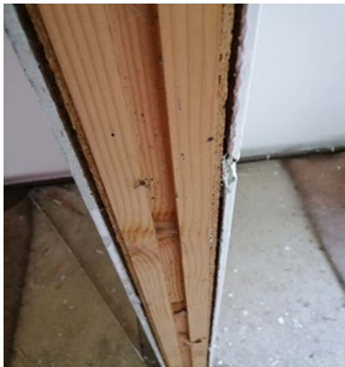
Унутрашњи зидови – дрвени панели са испуном од минералне вуне и зидани зидови
