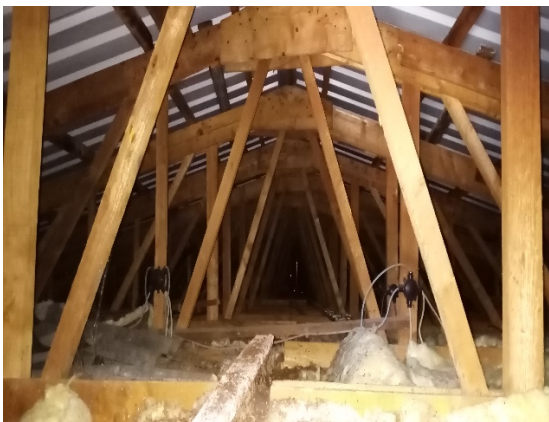
Дрвени решеткасти кровни везачи са кровним покривачем од трапезастог лима и салонита
