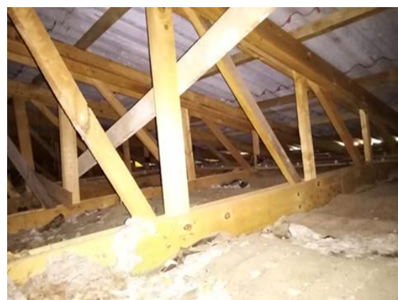
Дрвени решеткасти кровни везачи са кровним покривачем од трапезастог лима и салонита
