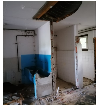
Унутрашњи зидови – дрвени панели са испуном од минералне вуне и зидани зидови
