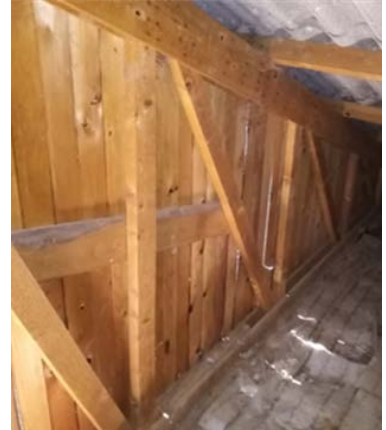
Дрвени решеткасти кровни везачи са кровним покривачем од трапезастог лима и салонита
