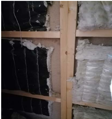
Унутрашњи зидови – дрвени панели са испуном од минералне вуне и зидани зидови
