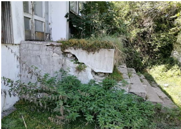
Оштећење улазних степеништа и трема
