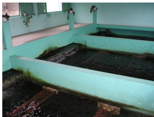
Слике 51-54. ППВ „Калифер“ -реактор/флокулатор, ламелни таложник и филтери
