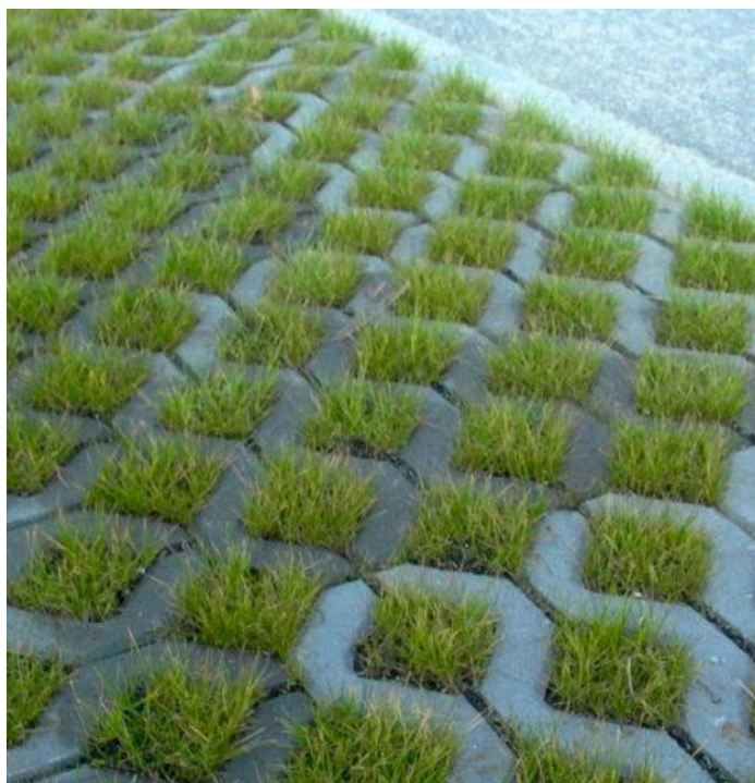
Betonske raster ploče-završna obrada površina platoa i parkinga
