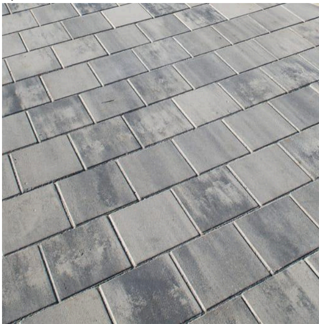
Betonske ploče-završna obrada površina platoa, staza i trotoara
