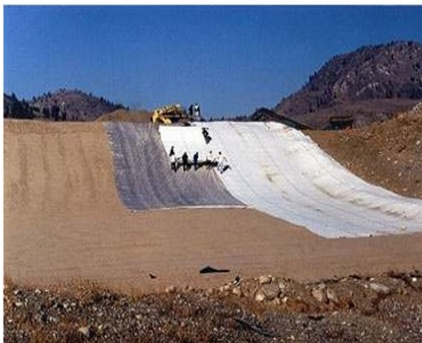
Слика – постављање доње непрпусне фолије
