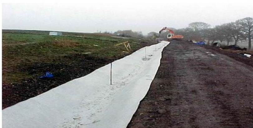
Слика – депонија са ободним каналима за отицање воде са фолије
